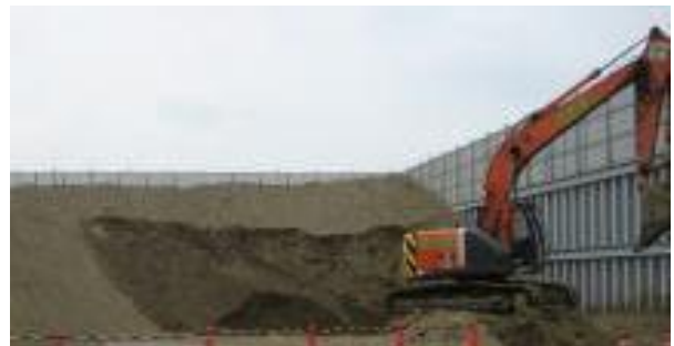
遮断砂第2ストック施設 ... 敷地面積 2,000 m 2 保管数量 10,000 m 3
