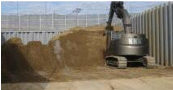
遮断砂第1ストック施設 ... 敷地面積 2,000 m 2 保管数量 10,000 m 3
